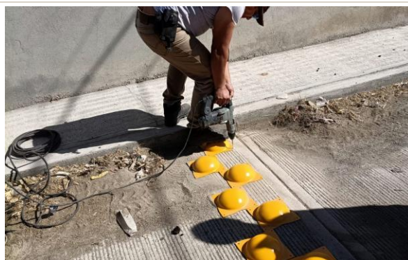
Fijación de los elementos reductores sobre el pavimento.
