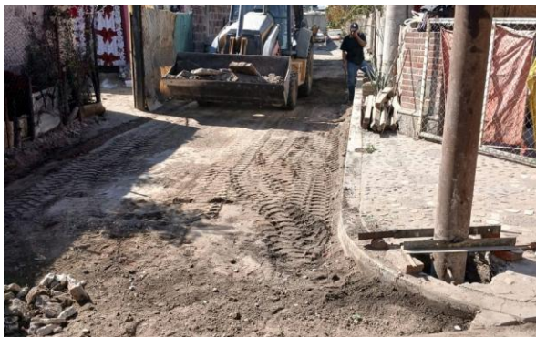
Preparación de la calle Nicolás Bravo para los trabajos de pavimentación.
