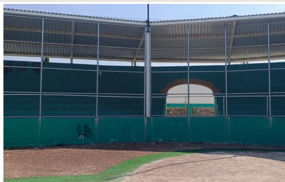
Vista interior de las adecuaciones realizadas para recibir el campeonato.
