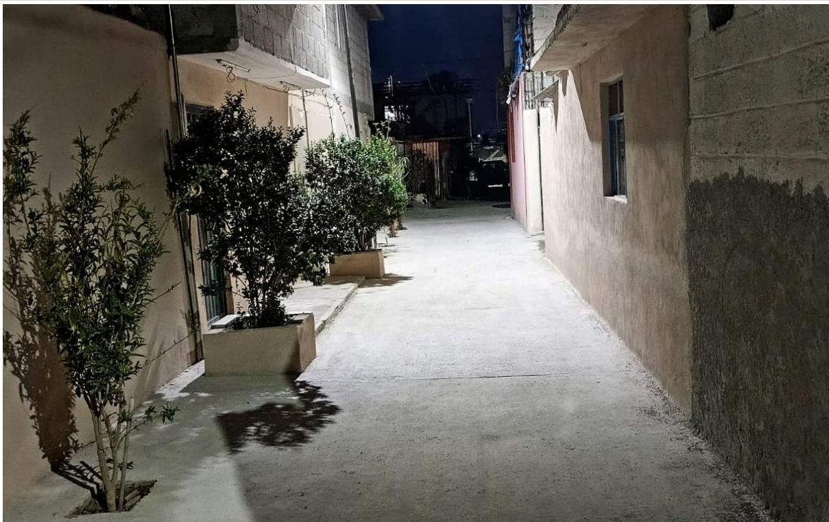
Resultado nocturno: calle pavimentada e iluminación en funcionamiento.
