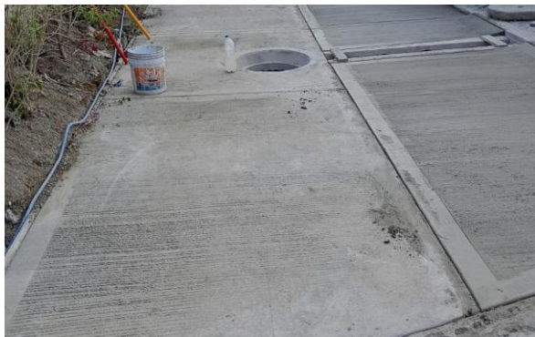
Avance del colado de concreto en la calle Nicolás Bravo.
