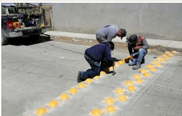
Proceso de instalación de reductores de velocidad en calle Juan Escutia.
